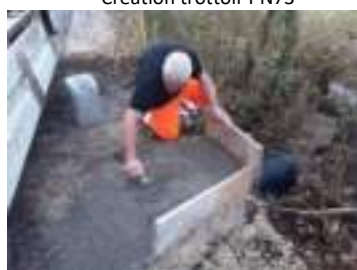
Réfection de la tête de pont, buse traversant la rue des chênes
