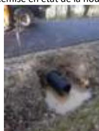
Réfection de la tête de pont, buse traversant la rue des chênes
