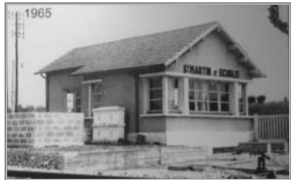
Poste d'aiguillage ligne ST-MARTIN-D'ECUBLEI à Conches
