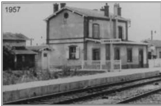
La gare SNCF du Mesnil « station ST-MARTIN-D'ECUBLEI » Ligne Paris /Granville
