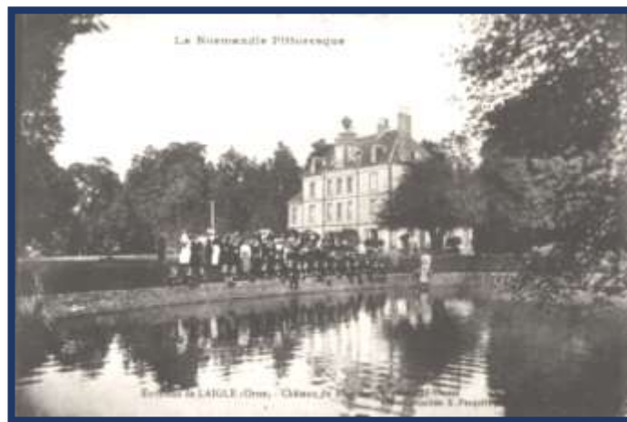
Château du Bois-Bertre, côté sud-ouest
