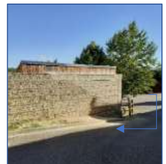
Réfection mur tombé suite tempête
