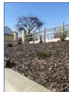
Plantation d'arbustes sur talus
